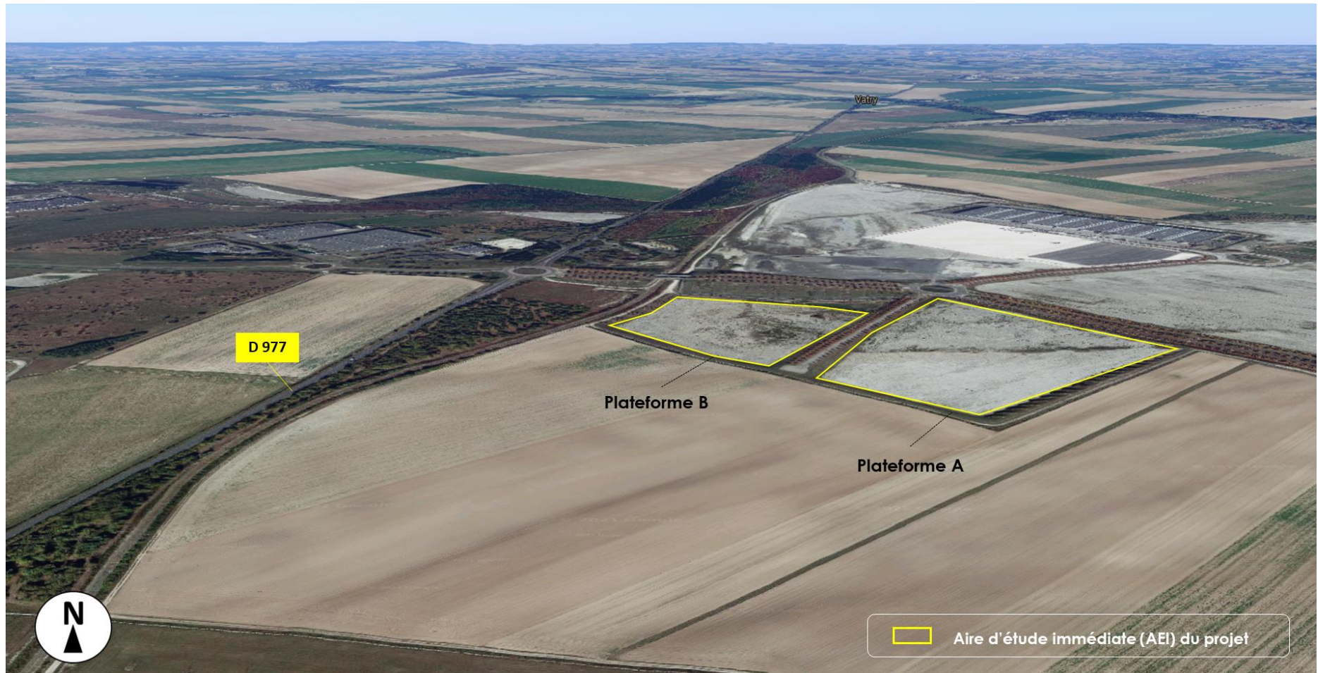
Ci-dessus, vue aérienne des emprises concernées par le projet d'implantation de plateformes logistiques au sein de l'emprise de la ZAC 2 - 2021 – ZAC 2 - Aéroport Paris-Vatry - Bussy-Lettrée (51) - Fond cartographique ©2021 GOOGLE / Landsat/Copernicus..
